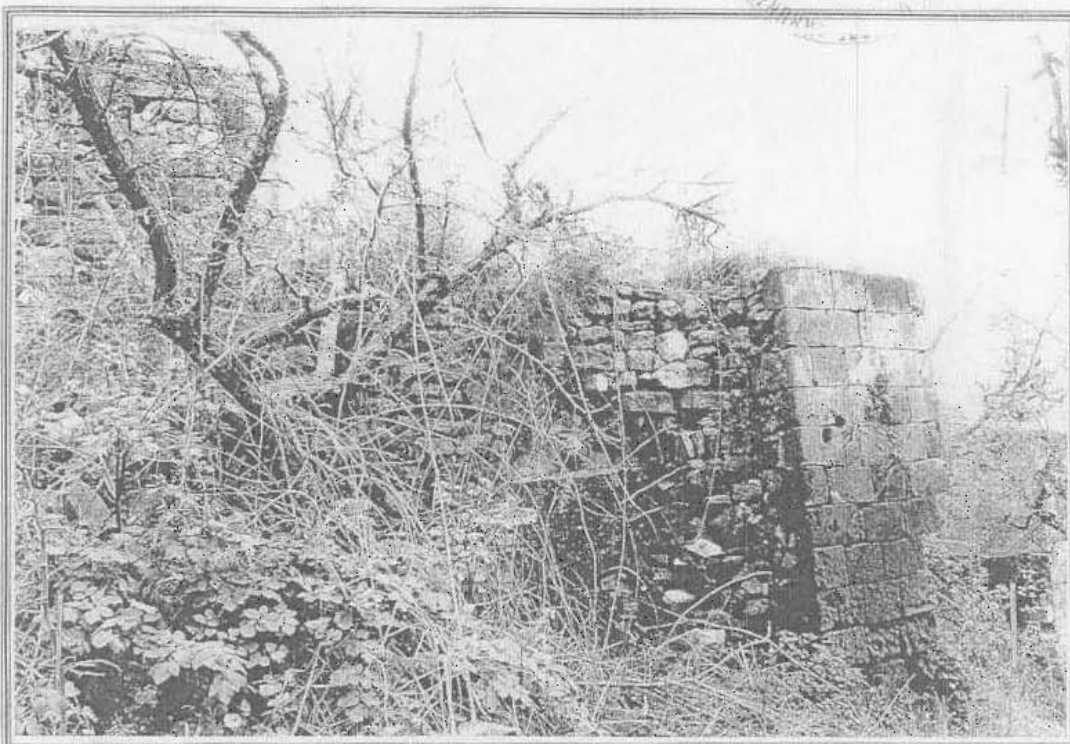
Foto n. 6 Fabbricato rurale, lato Sud con solaio di copertura crollato
