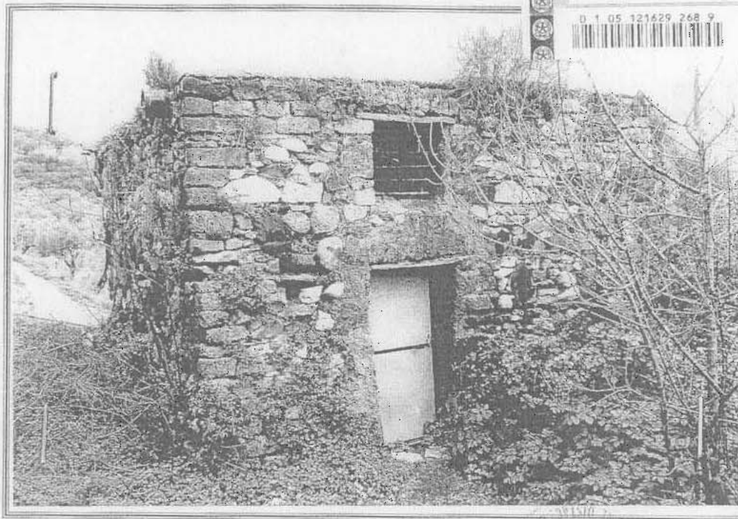
Foto n. 5 Fabbricato rurale, prospetto Ovest
